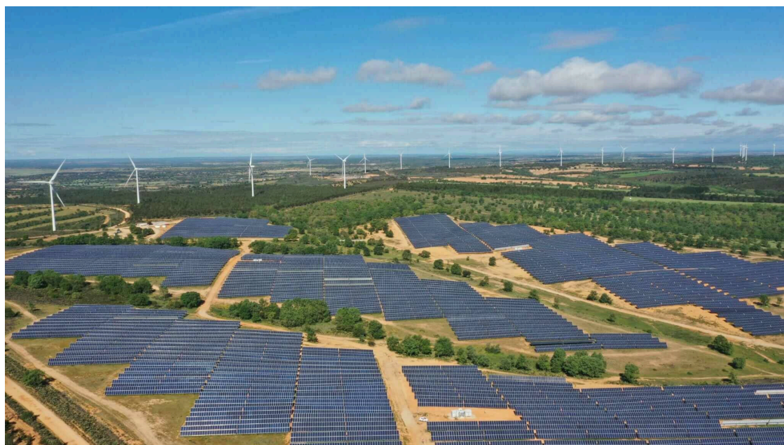
Vista de las placas fotovoltaicas en Usagre. (A.F.)
